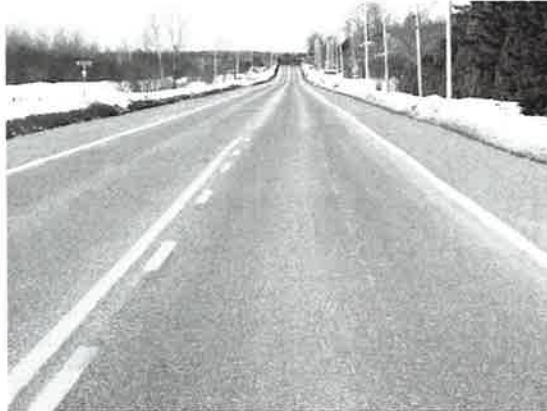
Photo 6101-2 Exemple de chaussée dégagée (route nationale)
