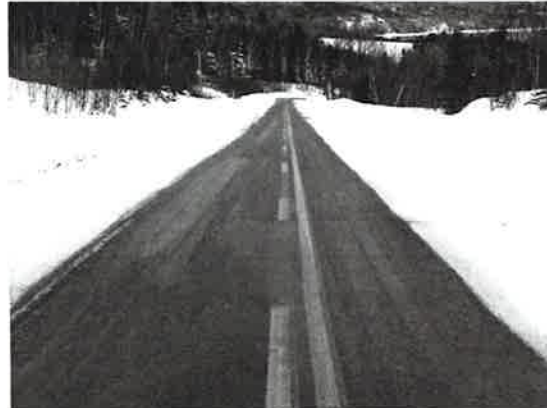
Photo 6101-3 Exemple de chaussée partiellement dégagée
